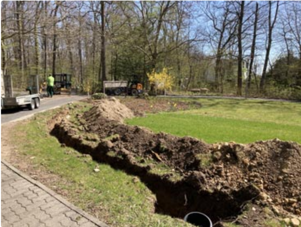
Baustelle an der Einfahrt Altkönigstraße der LThH
